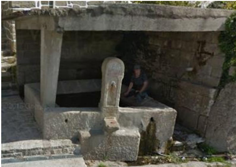
Fig.1 - Tanque público do lugar de Cousso, concelho de Melgaço
